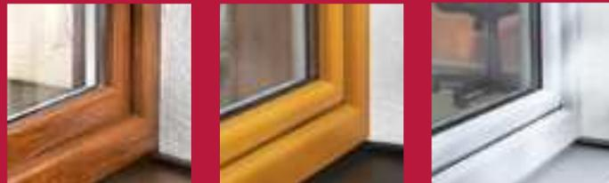
Con el nuevo sistema S 8000 IQ plus GEALAN responde a una exigencia central de la normativa sobre ahorro energético, es decir al mejoramiento del aislamiento térmico de edificios. Para satisfacer esta exigencia, el nuevo sistema de junta tope dispone de 6 cámaras y 83 mm de profundidad de construcción. Con ello los fabricantes de ventanas con perfiles
